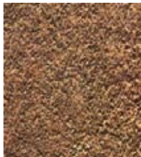
Stahloberfläche, von der der Zunder weggerostet ist oder sich abschaben lässt, die aber nur wenige, für das Auge sichtbare Rostnarben aufweist
